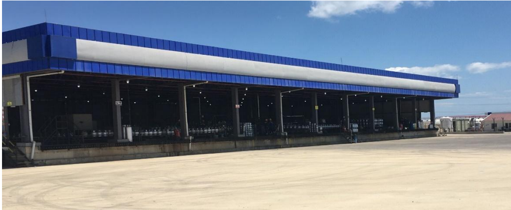
Tüp Dolum Rampası
